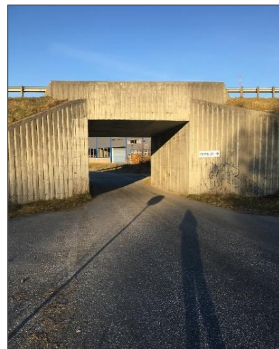
Figur 5 Kulvert på Kongshaugstranda under E39 (foto: Norconsult)
