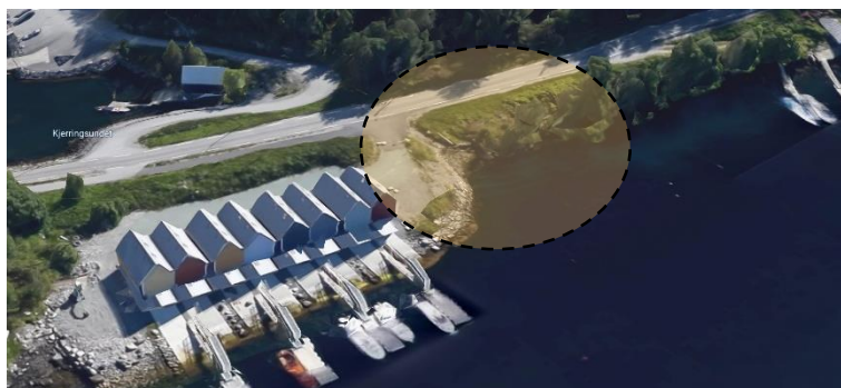
Figur 3 Plassering av utfylling og ventilkum sett fra sjøen.
