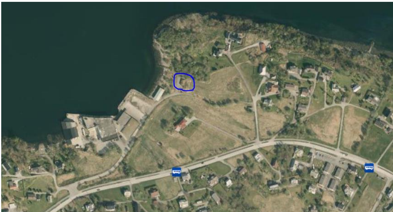
Figur 20: Flyfoto over området. Eksisterende renseanlegg er markert med blå sirkel.
