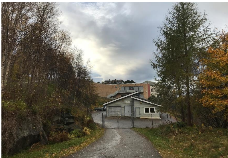
Figur 4: Renseanlegget RA3 Larsgården. Vest for renseanlegget ligger en trafostasjon med tilhørende administrasjonsbygg (rødt murbygg). På kollen bak ses boligbebyggelse. Foto (begge): Norconsult AS.
