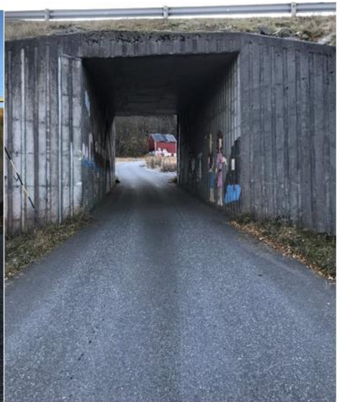
Bilde 3: Kulvert i Kvasnesvegen
