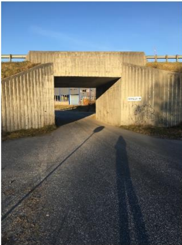
Bilde 2: Kulvert i Kongshaugstranda
