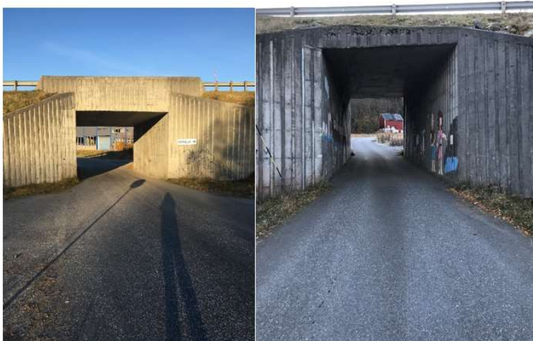
Til venstre: kulvert i Kongshaugstranda. Til høgre: kulvert i Kvasnesvegen.
