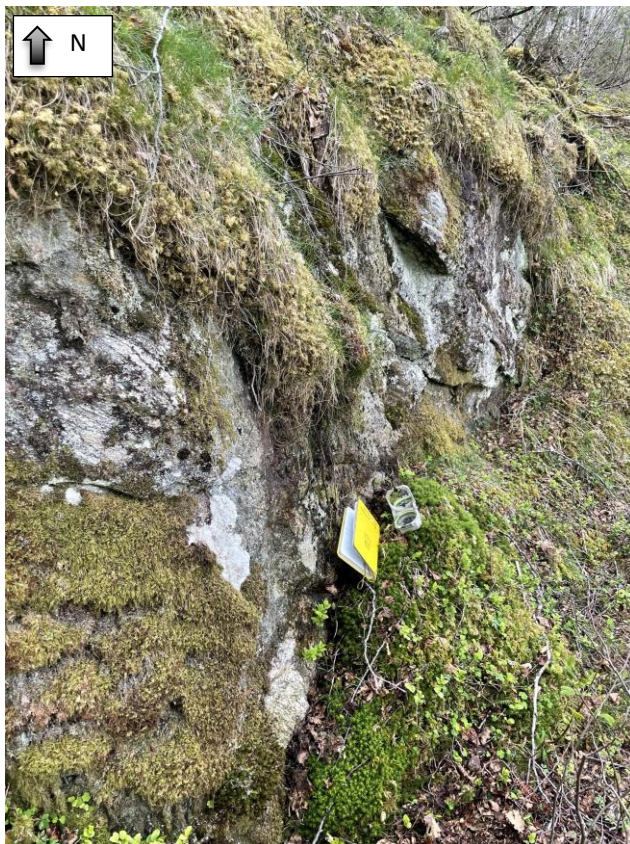
Figur 7: Bergblotning ved Infopunkt 5.
