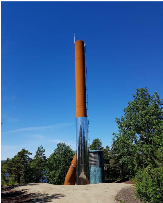
Odderøya avløpsrensanlegg Kristiansand
