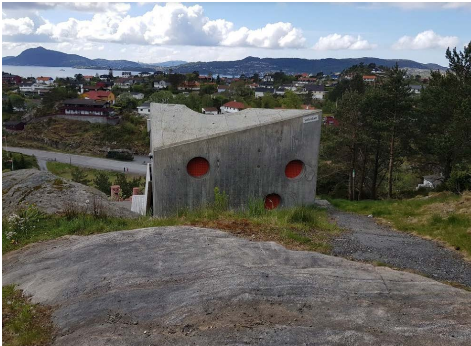
Kvernevik avløpsrenseanlegg Bergen
