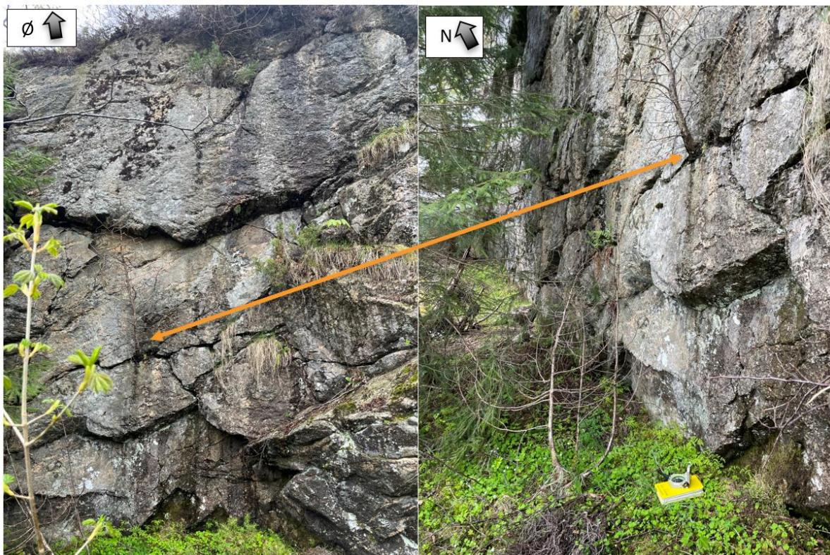
Figur 6: Bergblotning ved skrent i Breidalen. Detaljbilde vinkelrett og parallelt på vertikalt sprekkesett. Oransje strek markerer et lite tre som vokser i en sprekk. Infopunkt 4.
