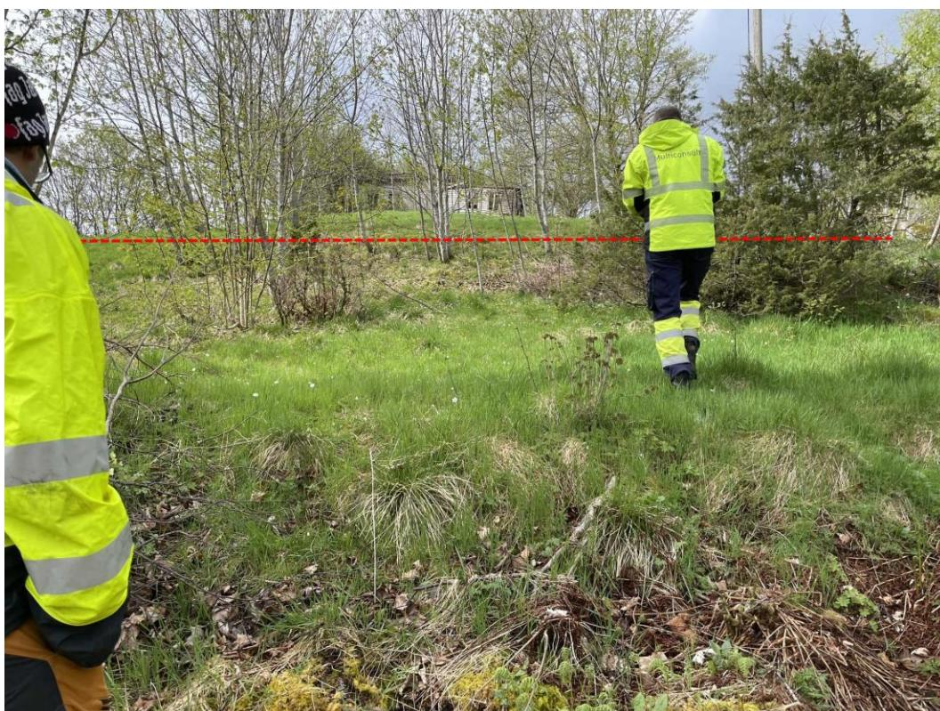
Figur 15: Oversikt over terrenget ved tomten for administrasjonsbygget. Planlagt skjæringstopp for skjæringen bak administrasjonsbygget er skissert med rød, stiplet strek. Selve påhuggsflatene for tunnelene blir stående like i forkant av bygningen i bildet. Foto er tatt mot vest.
